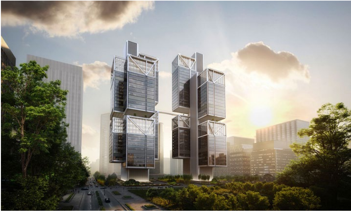
Ilustración 14. DJI campus. Fuente, Google
