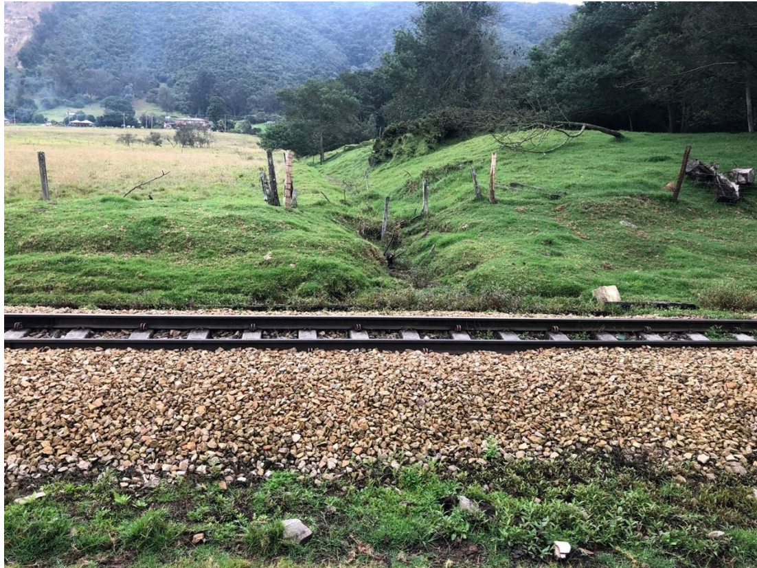
Imágen 1: Cuenca hídrica Quebrada San Juan interrumpida por la vía férrea.
