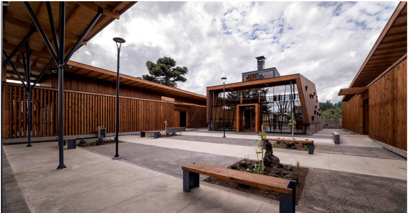
Figura 5.10. Vista parcial Centro de Acopio de Curacautín.
