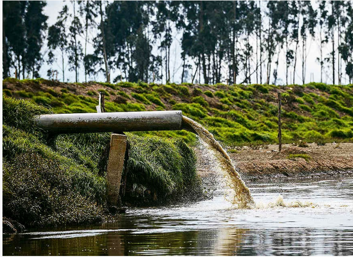
Vertimientos ilegales en el Río Bogotá
